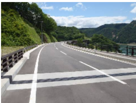
写真-3 路面状況
