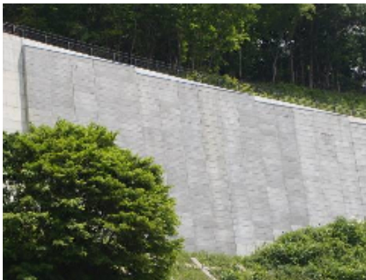
写真-2 壁面状況
